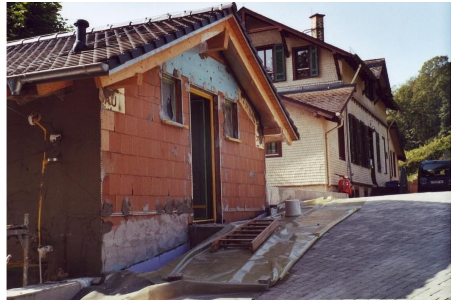
Bauzustand im Herbst 2005
