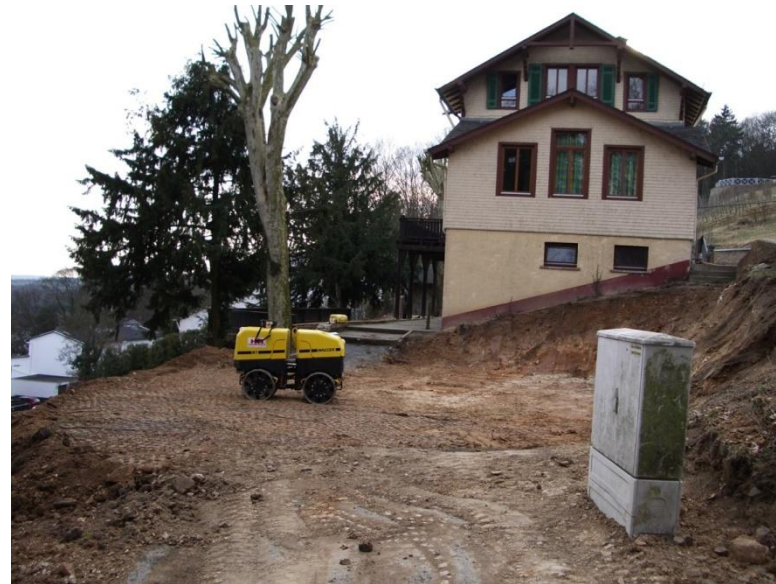
Bauplatz des Vereinsheims im Winter 2004/2005
