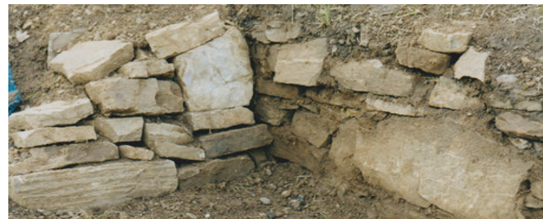
Historische Bruchsteinmauer des Weinbergs aus dem 19. Jh.
