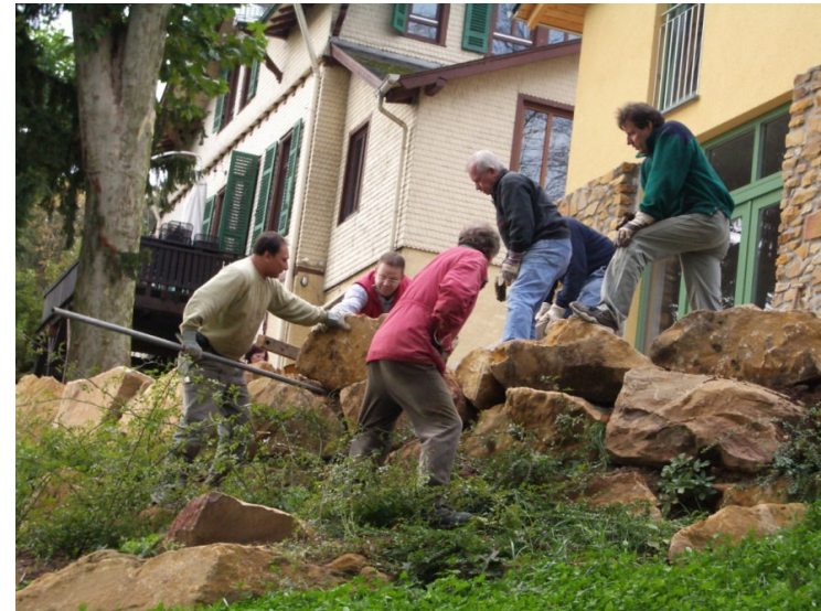
Schwerstarbeit bei den Außenanlagen
