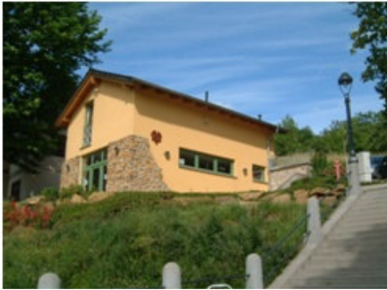
Das Vereinsheim nach der Fertigstellung
